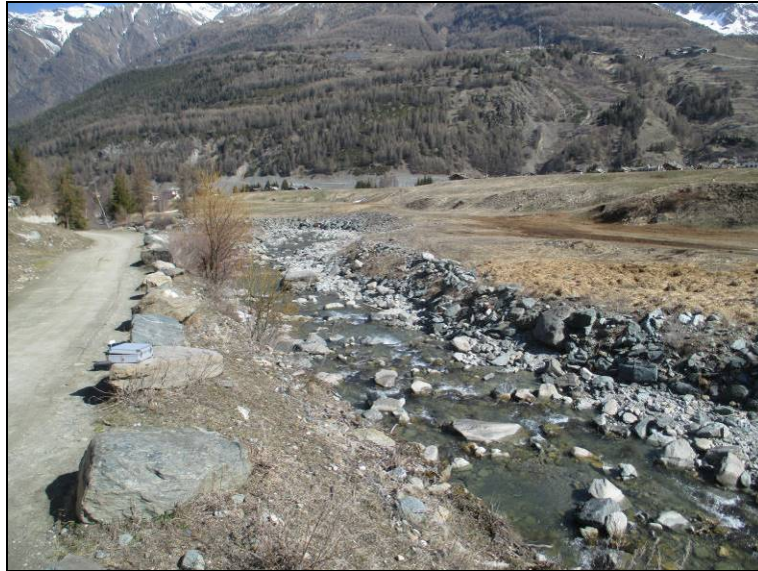
Vista del settore di realizzazione della condotta forzata
