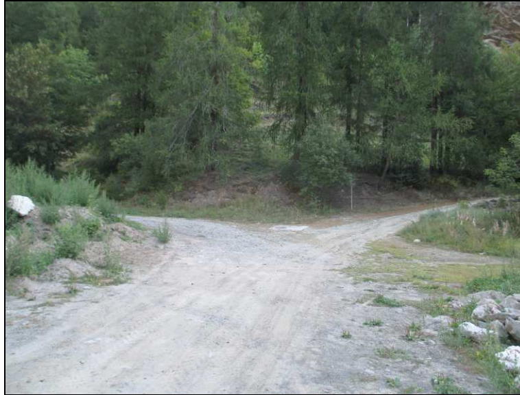
Vista del settore di realizzazione della centrale di produzione
