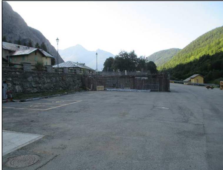
Vista del settore di realizzazione della cabina di consegna
